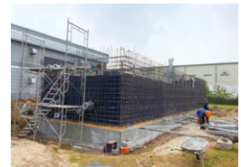
ภาพการก่อสร้างติดตั้งถังน้ำดับเพลิงสำหรับสปริงเกอร์
