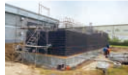
スプリンクラー用の消火水槽建設工事のようす
