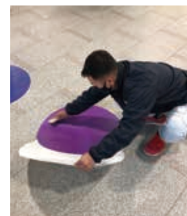
フロアマーキングを施工するようす
