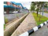
涂刷后的黑白警示线
