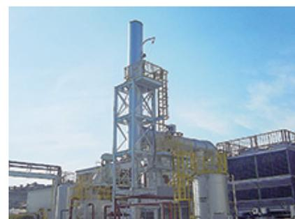
熊谷工場に導入されたガスエンジンコージェネレーションシステム
