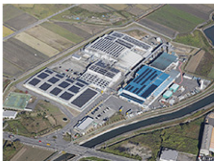
土居加工工場では太陽光パネルを設置
