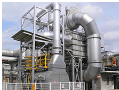
排熱ボイラーを更新し省エネルギー化へ
