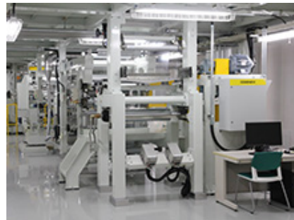
量産化テスト塗工設備
