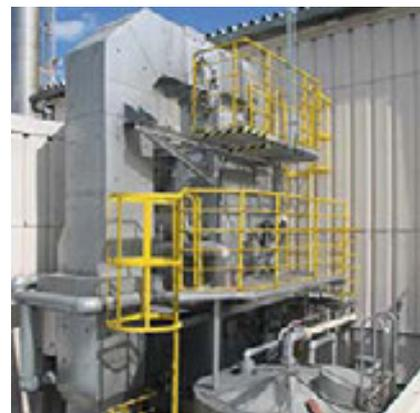
龍野工場の焼却炉ボイラーに設置したエコマイザー
