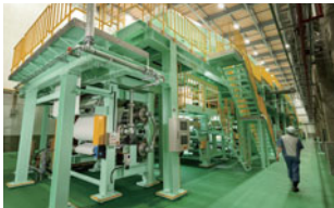
小松島工場(徳島県)の新設備
