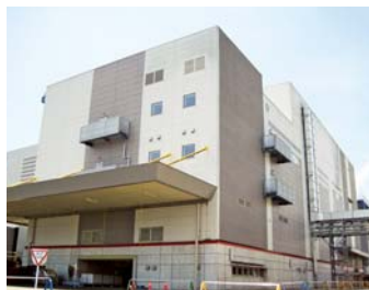
新設備を導入する吾妻工場の既存工棟
