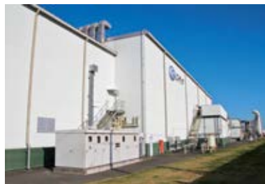
熊谷工場の既存工棟
