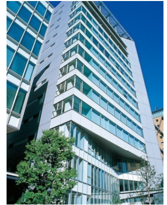
日射調整フィルム施工イメージ
