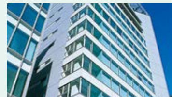
日射調整タイプのウィンドーフィルム施工イメージ
