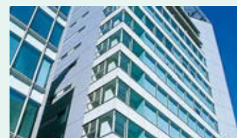
日射調整タイプのウィンドーフィルム施工イメージ
