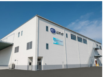
小松島工場の新工棟
