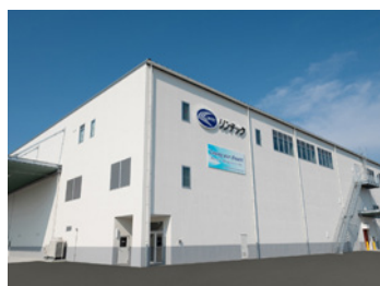
小松島工場の新工棟
