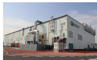
熊谷工場に増設した積層セラミックコンデンサ関連テープの新工棟
