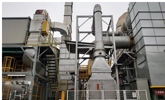
Regenerative thermal oxidizer (RTO)
