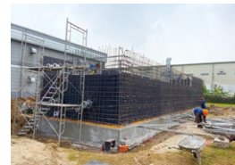
Kerja-Kerja Pembinaan Tangki Air Pemadam Kebakaran Untuk Perenjis
