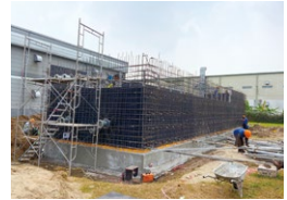
스프링클러용 소화 수조 건설 공사의 모습
