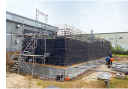
Suasana proyek pada tangki air pemadam kebakaran untuk alat penyiram
