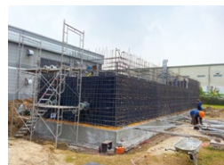
灑水裝置用消防水箱的施工現場
