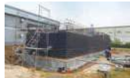
スプリンクラー用の消火水槽建設工事のようす
