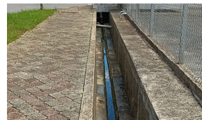
清掃が行き届いた側溝
