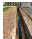
彻底清理后的排水沟
