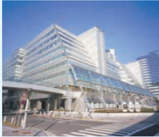
อาคารซึ่งสร้างขึ้นด้วยฟิล์มติดกระจกที่สามารถลดความร้อนจาก แสงอาทิตย์ได้
