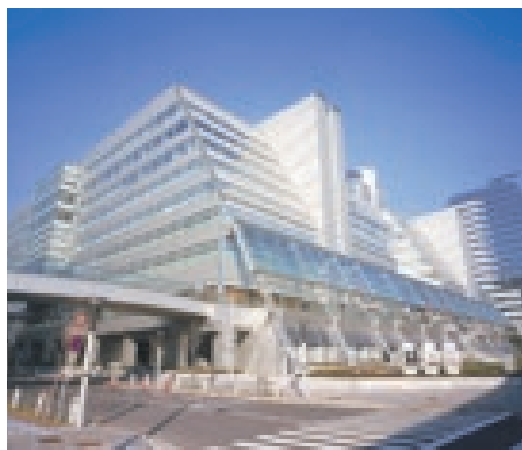
貼有窗膜，可隔熱的建築物
