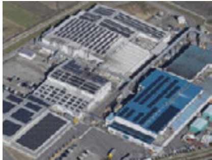
土居加工工場に設置された太陽光パネル (約10,000m 2 )
