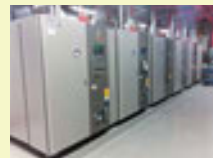
Pengurusan operasi enam buah pemanas dalam kombinasi optimum
