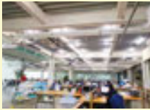
交換したLED照明
