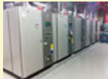
6台のボイラーを最適な組み合わせで運転管理
