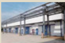
第二工廠危險物品倉庫外觀
