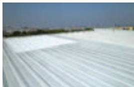
隔熱塗裝的實地測試
