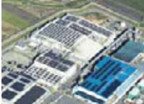
土居加工工場に設置された太陽光パネル (約10,000㎡)
