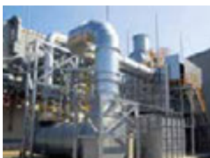
環境への負荷を減らす取り組み。 左：土居加工工場の排熱ボイラ。右：三島工場のLNGサテライト設備。
