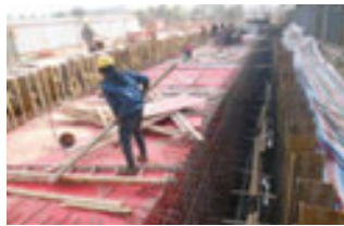
유출방지용 긴급 폐수 저수조 공사
