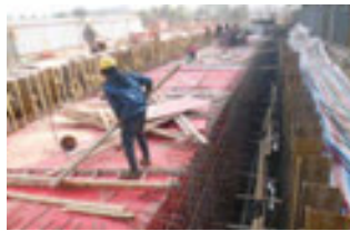
Pembuatan bak penampungan air limbah darurat untuk mencegah pembuangan limbah ke luar.
