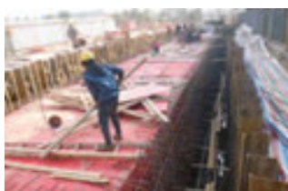
防止外流的緊急廢水貯水槽工程
