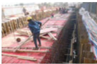
修建防止废水外流的紧急废水储水罐
