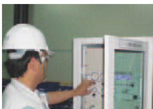
VOC自動監視測定裝置
