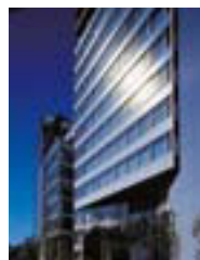
断熱フィルム施工例
