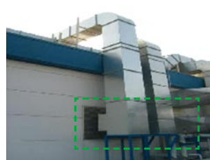
Saluran masuk dan saluran keluar untuk asap ekzos yang digunakan semula
