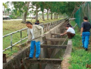
Pembersihan Saluran Air di Sekitar Pabrik
