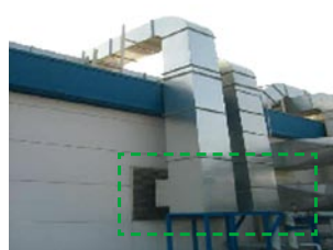
Saluran Keluar/Masuk Gas Buangan yang Dipakai Kembali
