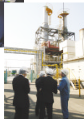
都市ガスに燃料転換した コ-ジェネレーション設備を見学
