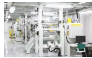
先端技術棟に導入された大型テスト塗工設備
