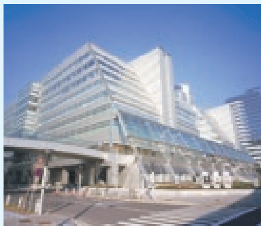
采用了可阻挡太阳辐射热量的窗膜的建筑物
