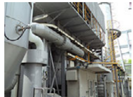
排ガス処理装置の外観
