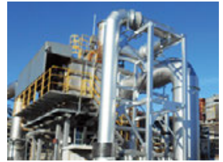
千葉工場に設置した排熱ボイラー
