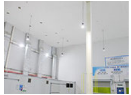
倉庫内のLED照明
