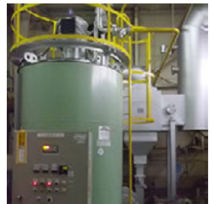
熊谷工場の燃焼空気予熱器
