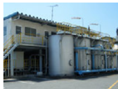
三島工場の排水処理設備
