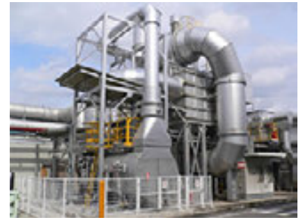
新宮事業所に設置した排熱ボイラー
