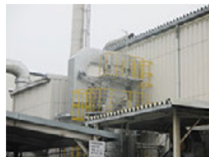
焼却炉ボイラーにエコノマイザーを設置 (龍野工場)
