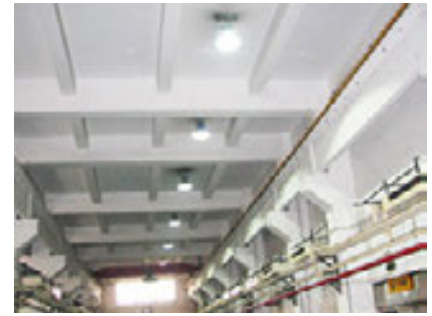
組立現場のLED照明
