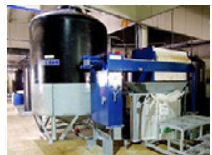
排水処理設備
