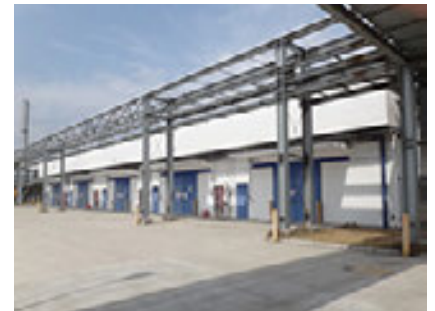
第2工棟危険物倉庫の外観
