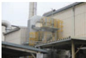
焼却炉ボイラーにエコマイザーを設置(龍野工場)
