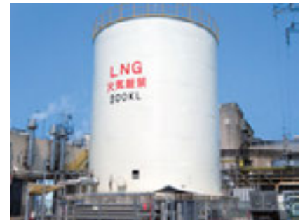
三島工場のLNGサテライト設備
