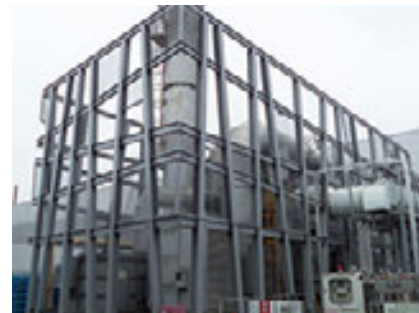
排ガス処理装置の外観
