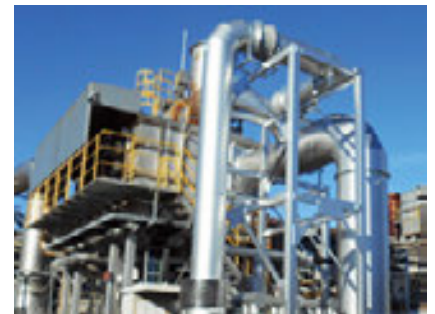
千葉工場に設置した排熱ボイラー
