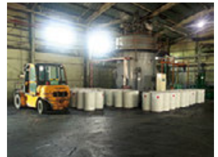
燃料化処理施設
