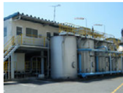
三島工場の排水処理設備
