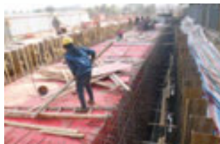
Pembinaan tangki air buangan kecemasan untuk menghalang pembuangan
