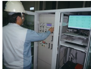
VOC自動監視測定裝置
