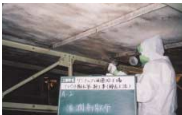
アスベスト除去作業（熊谷工場）
